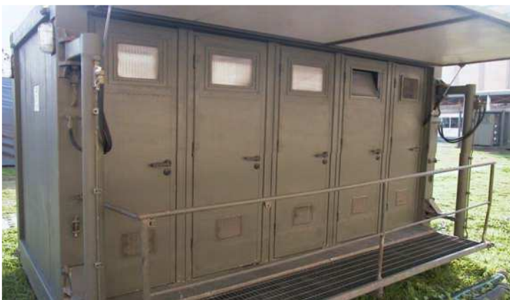
foto n. 3 - Particolare passerella UEO2
