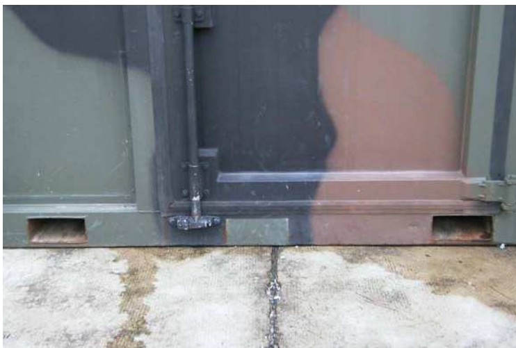
foto n. 7 – Particolare delle tasche per il sollevamento dello shelter
