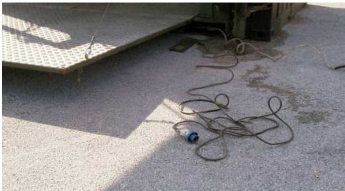
foto n. 6 – Cavo alimentazione elettrica
