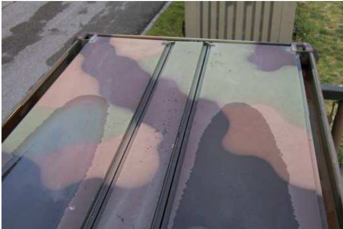
foto n. 9 - Tetto dello shelter
