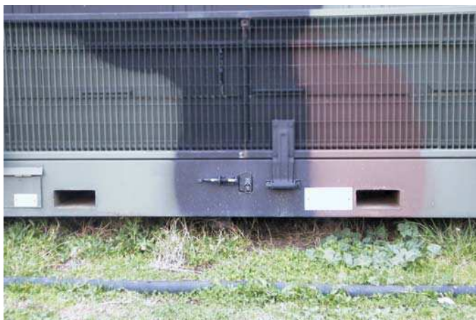
foto n. 7 - Tasche per il sollevamento a mezzo carrello
