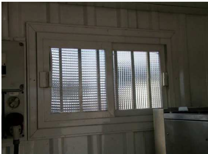
foto n. 3 – Finestra parete sinistra
