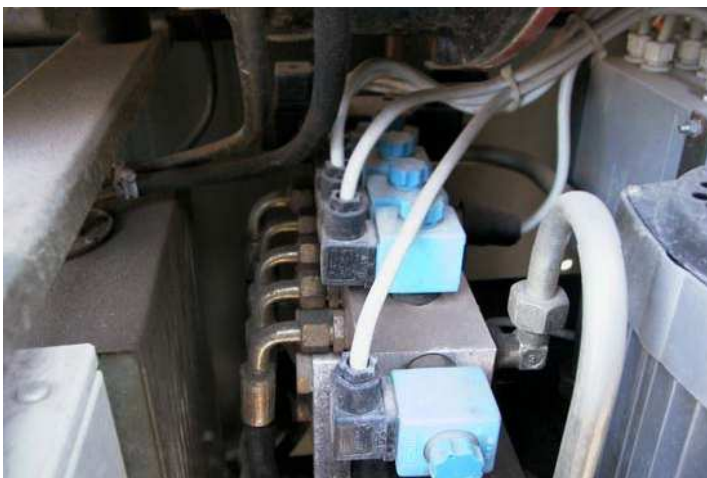
foto n. 12 – Distributori olio impianto sollevamento
