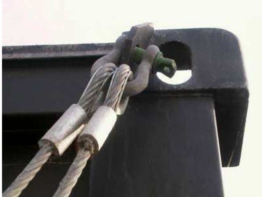
foto n. 8 – Fissaggio funi di ancoraggio
