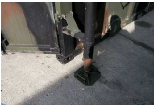
foto n. 7 – Particolare piastre di appoggio
