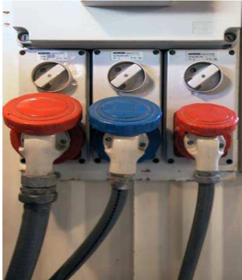
foto n. 18 - Prese di corrente interbloccate
