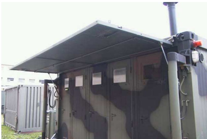
foto n. 6 - Tettoia di copertura
