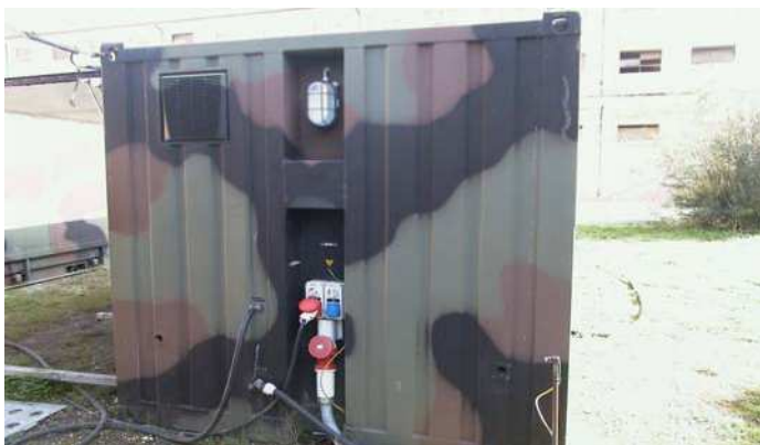
foto n. 5 – Vista parete anteriore shelter
