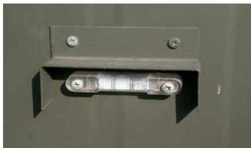
foto n. 3 – Livella controllo assetto shelter
