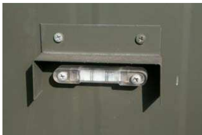
foto n. 5 – Livella controllo assetto shelter
