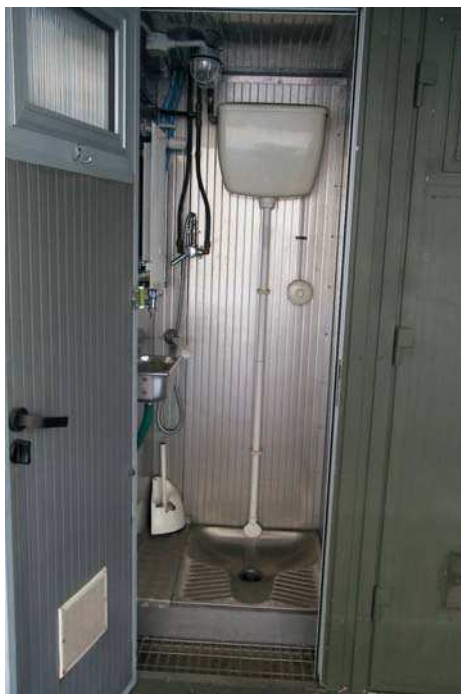
foto n. 7 - Cabina servizi igienici
